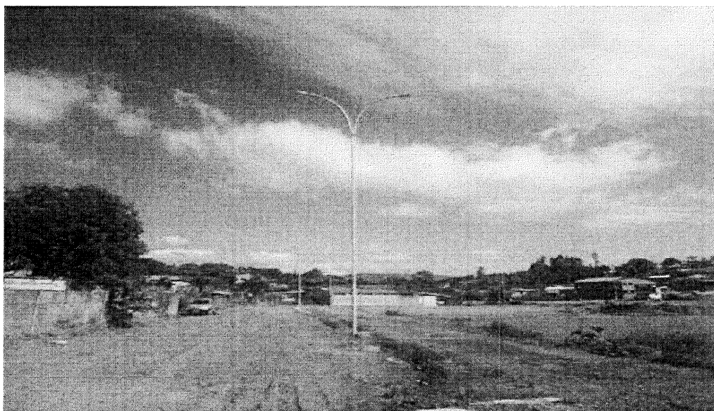
Foto 02: Trecho da Avenida Copacabana, para execução do calçamento do pavimento intertravado sextavado.
