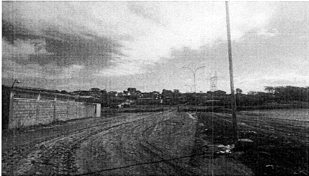
Foto 01: Trecho da Avenida Copacabana, para execução do calçamento do pavimento intertravado sextavado.
